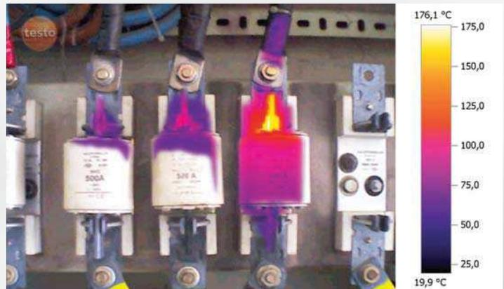
Наложение ИК аномалий на реальное фото позволяет быстро визуально определить неисправность.
